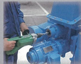
電動工具による開操作
